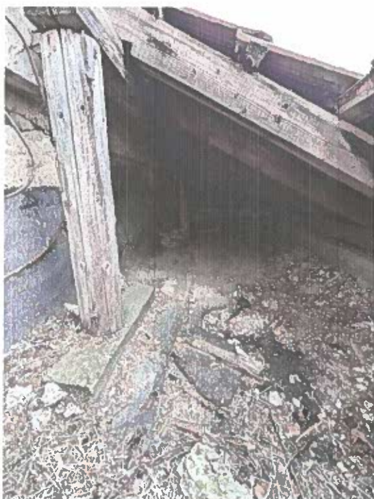
Poza 12&13 Șarpanta de lemn peste zonă de clădire parter prezintă degradări lipsuri nefiind etanșă la acțiunea ploi
