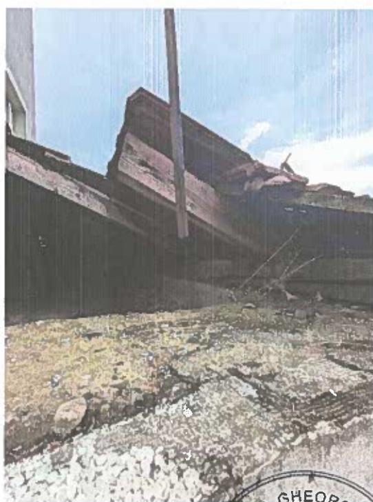
Poza 12&13 Șarpanta de lemn peste zonă de clădire parter prezintă degradări lipsuri nefiind etanșă la acțiunea ploi
