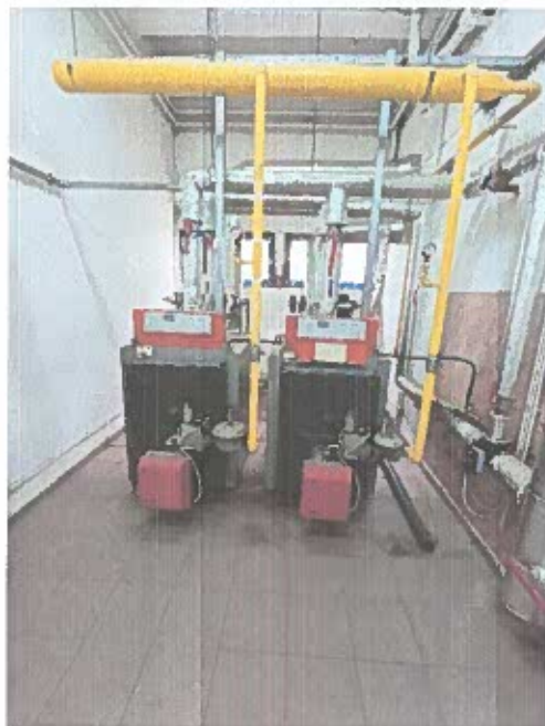
Poza 7. Poză din centrala termică, se observă cele două cazane care asigură încălzirea și prepararea apei calde de consum
