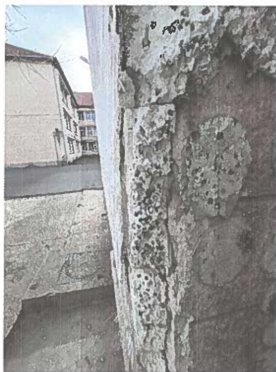
Poza 11 Izolația termică existentă este într-o stare avansată de degradare
